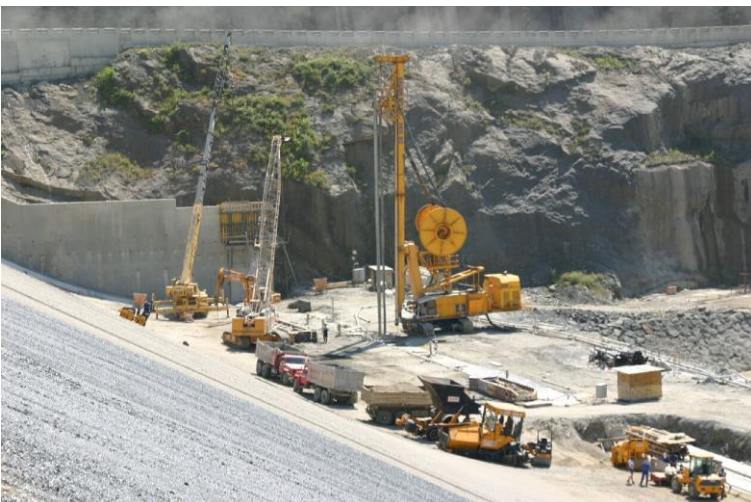
Schlitzwandherstellung im Mehrphasenverfahren (rechts: Schlitzwandfräse; Mitte: Schlitzwandgreifer
