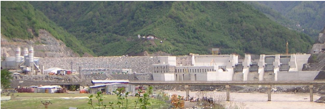
Kraftwerk Muratli – Übersicht über das Dammbauwerk und das Krafthaus
