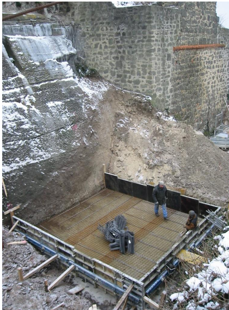
Maschinenraum Bergstation – Fundamentherstellung auf Bauschutt und Fels
