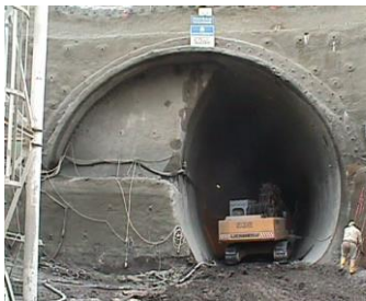
Ulmenstollenvortrieb zur Querung der Westbahn
