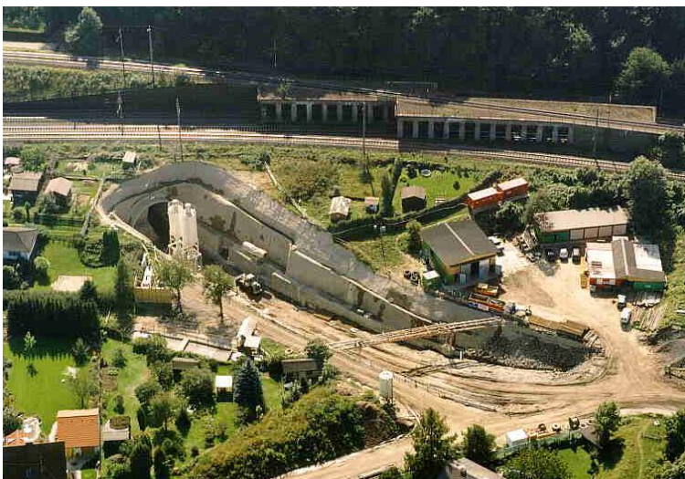
Voreinschnitt West des Mona-Lisa-Tunnels mit Querung der Westbahn
