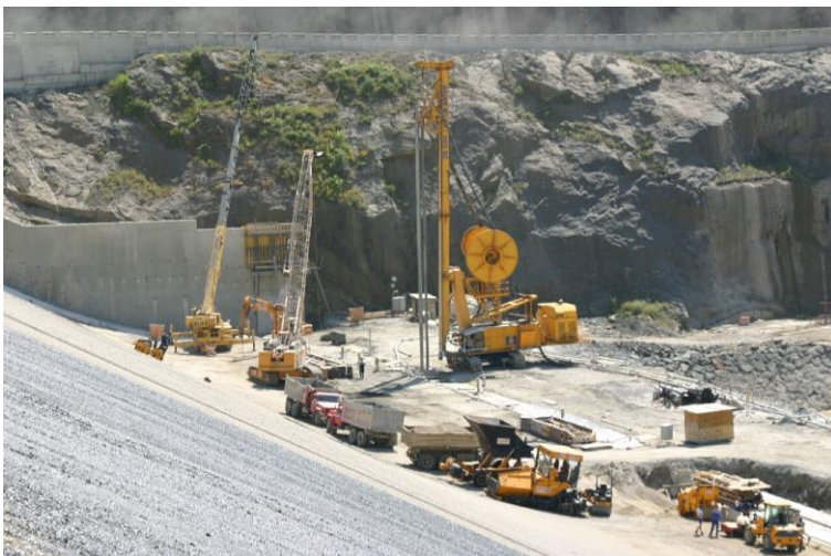
Schlitzwandherstellung im Mehrphasenverfahren (rechts: Schlitzwandfräse; Mitte: Schlitzwandgreifer
