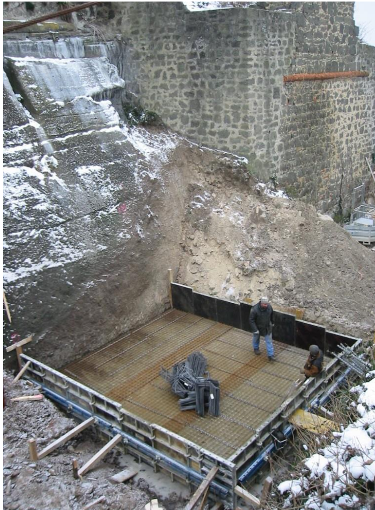
Maschinenraum Bergstation – Fundamentherstellung auf Bauschutt und Fels
